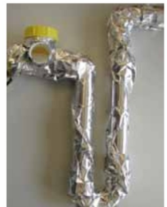
Sondersiphon druckseitig, Typ 100500 mit SBH-02 (2 Meter) mit Alu-Klebeband umwickelt, bessere Wärmeübertragung
