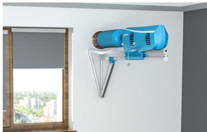
MIT DIAMANTBOHRERN EIN LOCH MIT DEM GEWÜNSCHTEN DURCHMESSER BOHREN
