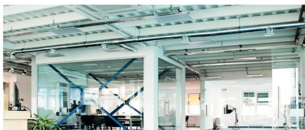
Die Lüftungsanlagen der industriellen Serie, die für die freie Aufstellung in Innenräumen konzipiert sind, werden mit Bügeln oder Schellen an der Unterlage befestigt. Der Anschluss der Ab- und Zuluftkanäle an die Lüftungsanlage erfolgt entsprechend der Auslegung der Lüftungsanlage.
